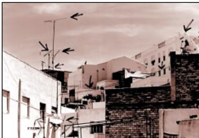
Vista exterior de una emisora pirata y detalles del cableado
